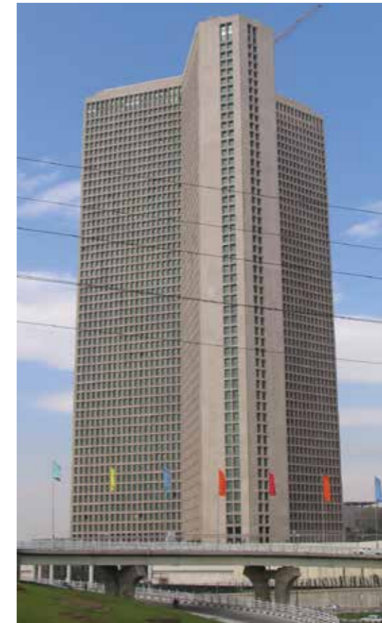
پروژه : برج تهران تهران
